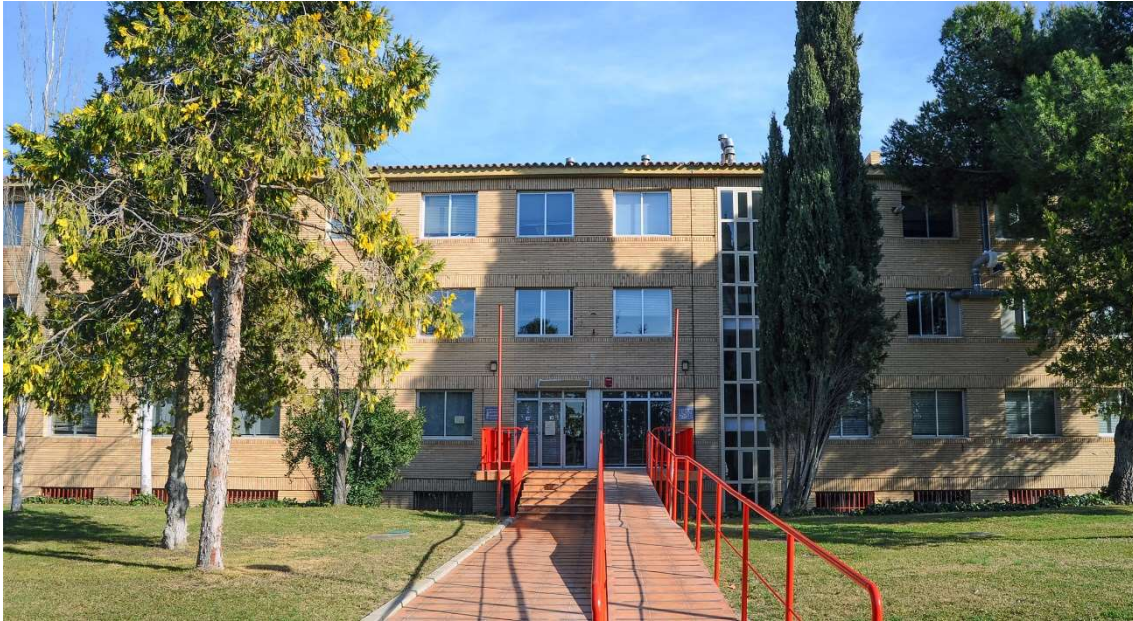
Imagen 15. Edificio que alberga los Laboratorios de Análisis Físico-Químicos. Edificio original del Laboratorio Agrario Regional del Ebro. Fondo documental del Laboratorio Agroambiental.
