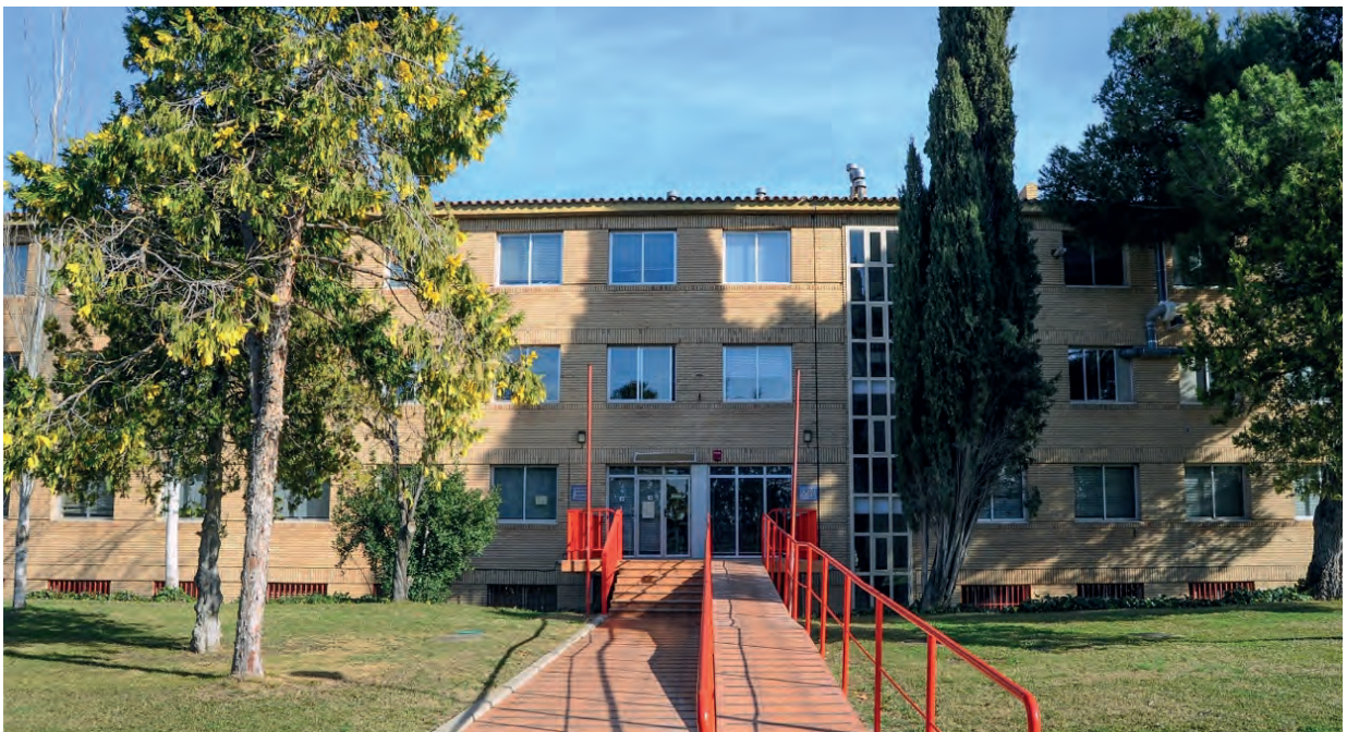
Imagen 19. Edificio que alberga los Laboratorios de Análisis Físico-Químicos. Edificio original del Laboratorio Agrario Regional del Ebro. Fondo documental del Laboratorio Agroambiental.
